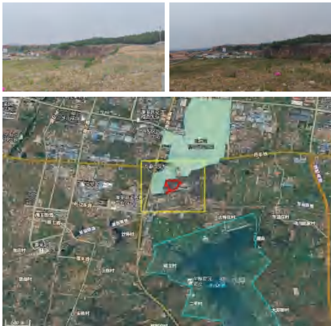
图 2-2 现状建筑垃圾填埋场
