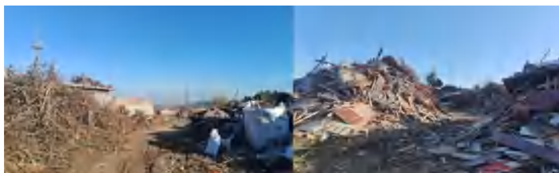
图 6-4 厂址现场照片
