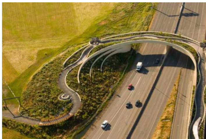
图 3-7 骑行道立体过街设施
